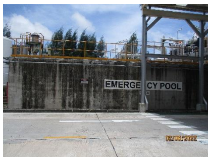
ภาพที่ 2.2-16 บ่อพักน้ำฉุกเฉินขนาด 1,500 ลูกบาศก์เมตร
