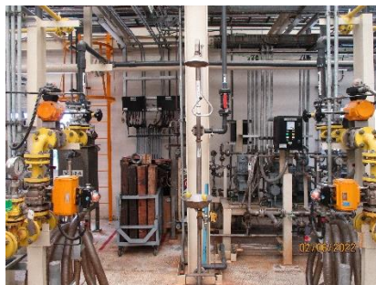
ภาพที่ 2.2-36 อ่างล้างตาและร่างกายในกรณีฉุกเฉิน
