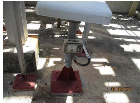
ภาพที่ 2.2-4 เครื่องตรวจวัดคลอรีน (Chlorine Gas Detector)
