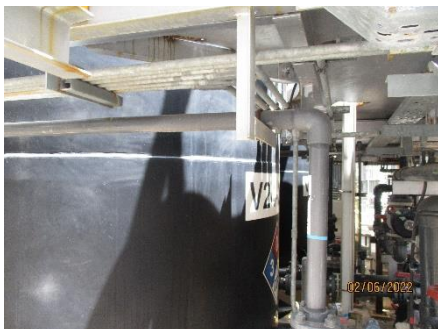
ภาพที่ 2.2-5 ถังสารละลาย NaOH 10% ที่มีการสำรอง
