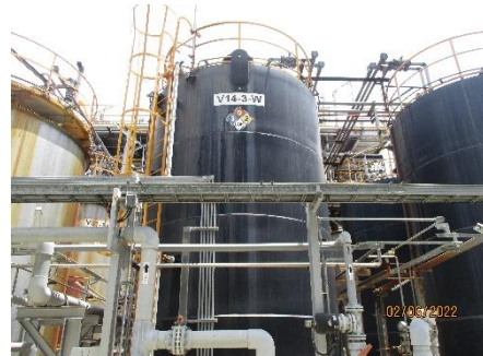
ภาพที่ 2.2-11 HCL Storage Tank
