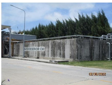
ภาพที่ 2.2-32 บ่อน้ำสำรองขนาด 1,200 ลูกบาศก์เมตร
